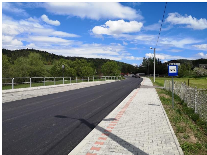
Rysunek 12. Wybrane zadania zrealizowane w ramach budowy chodników w 2020 roku
