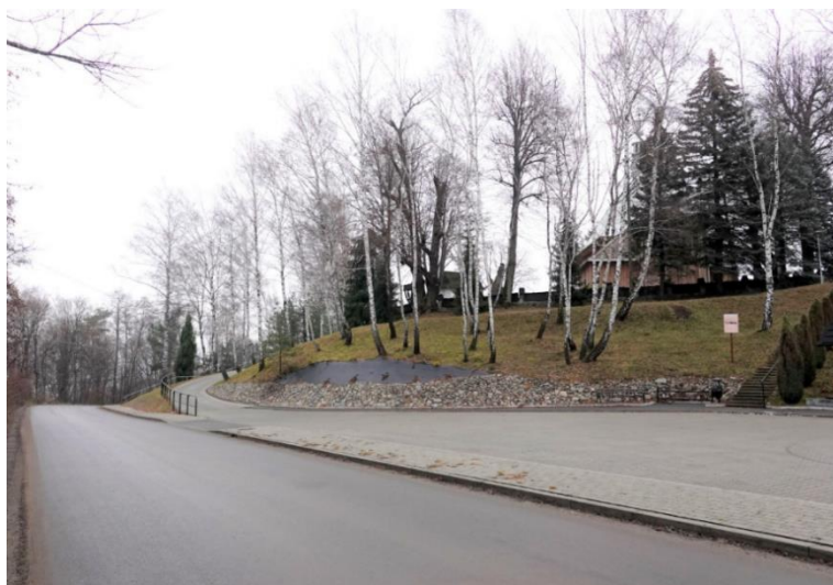
Remont drogi powiatowej nr 1449K Wytrzyszczka - Tropie - Bartkowa Posadowa w km 6+620 - 8+900
