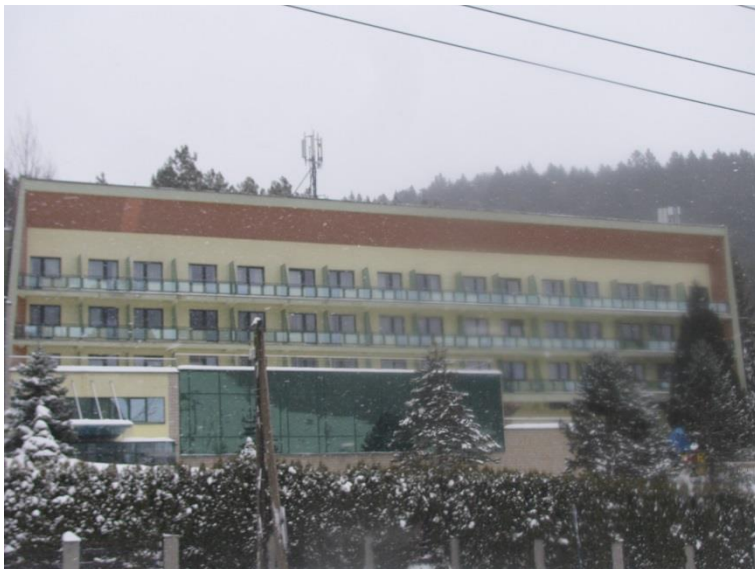
Zał. nr 1: Widok ogólny instalacji radiokomunikacyjnej.
