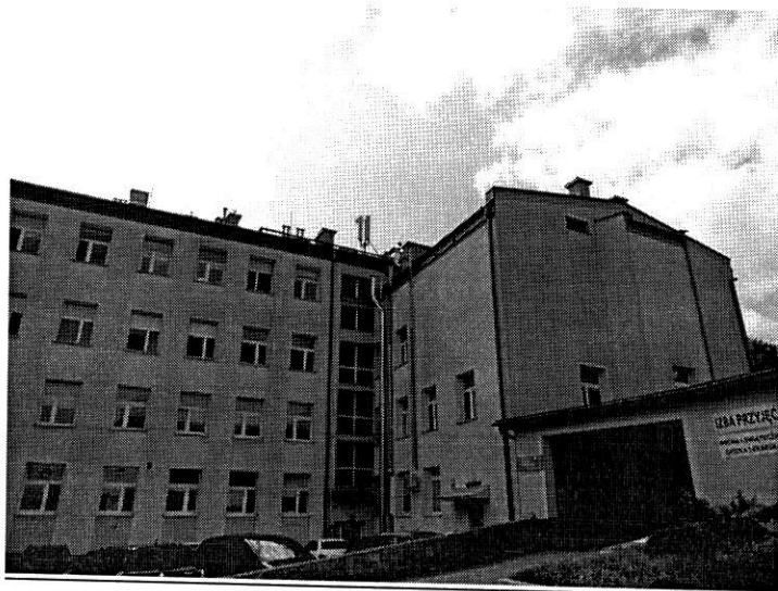
Zał. nr 1: Widok ogólny instalacji radiokomunikacyjnej.
