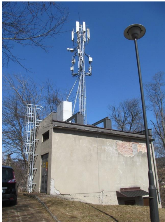
Zał. nr 1: Widok ogólny instalacji radiokomunikacyjnej.
