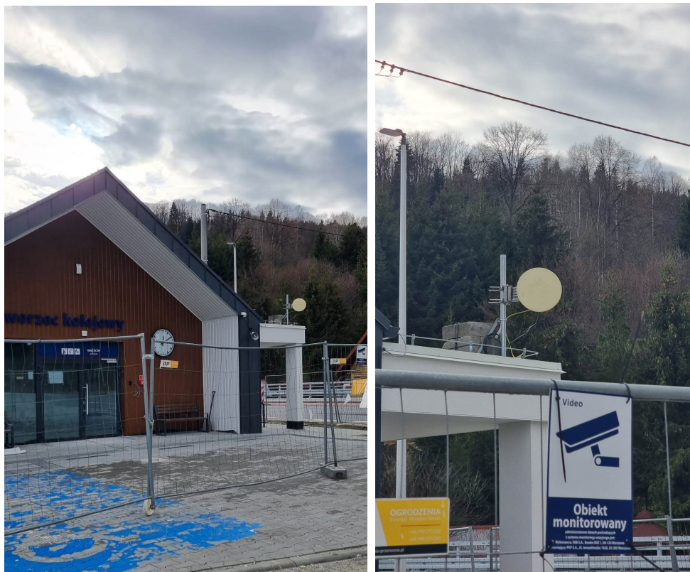
Widok obiektu wraz z zainstalowanym zespołem antenowym
