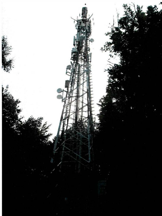
Zał. nr 1: Widok ogólny instalacji radiokomunikacyjnej.
